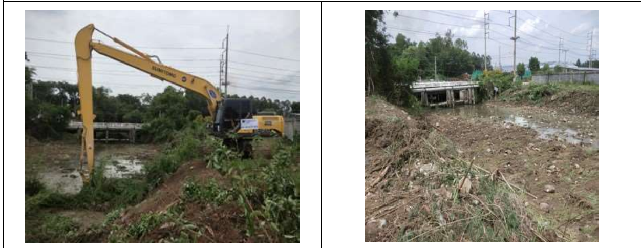
รูปที่ 25 การขุดลอกคลองสองคอน
