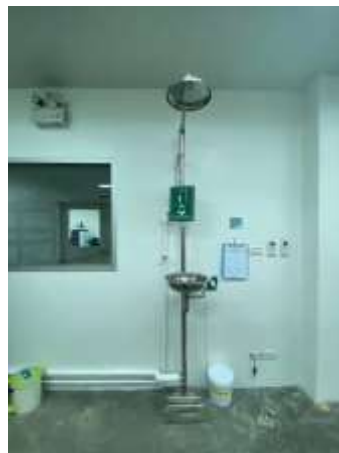
รูปที่ 34 ฝักบัวฉุกเฉิน และอ่างล้างตา บริเวณพื้นที่เสี่ยง
