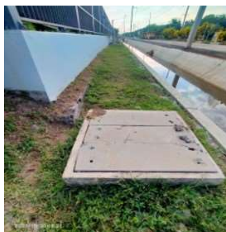
รูปที่ 4 ท่อรวบรวมน้ำเสียก่อนเข้า ระบบบำบัดน้ำเสียส่วนกลาง
