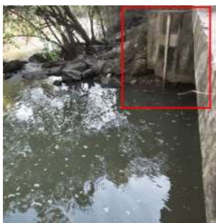
รูปที่ 38 การติดตั้งเสาวัดระดับความลึกของคลองสองคอน
