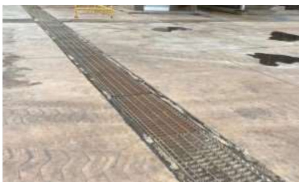
รูปที่ 6 ระบบท่อรวบรวมน้ำเสียของโรงงาน
