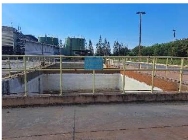
รูปที่ 3 บ่อพักน้ำทิ้งฉุกเฉินของโรงงาน
