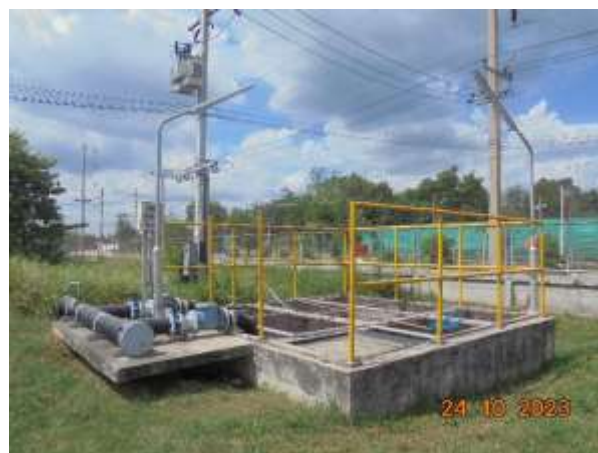
รูปที่ 10 ระบบบำบัดน้ำเสียส่วนกลางของนิคมฯ
