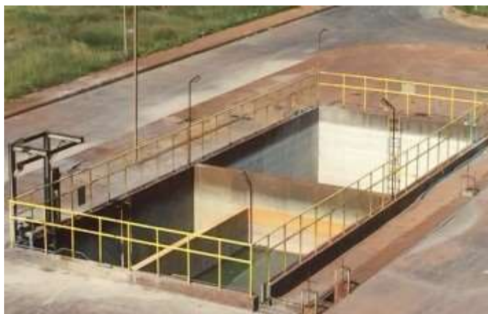
รูปที่ 5 ระบบบำบัดน้ำเสียเบื้องต้นของโรงงาน
