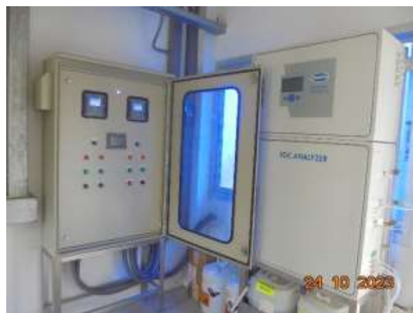
รูปที่ 14 การติดตั้งเครื่องตรวจวัด DO online และ BOD/COD online บริเวณบ่อพักน้ำทิ้ง (Holding Pond)
