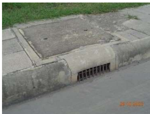
รูปที่ 7 ระบบระบายน้ำฝนของโรงงาน
